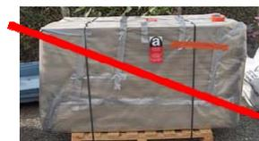
La palette doit être de taille supérieure ou égale aux plaques d'amiante.
