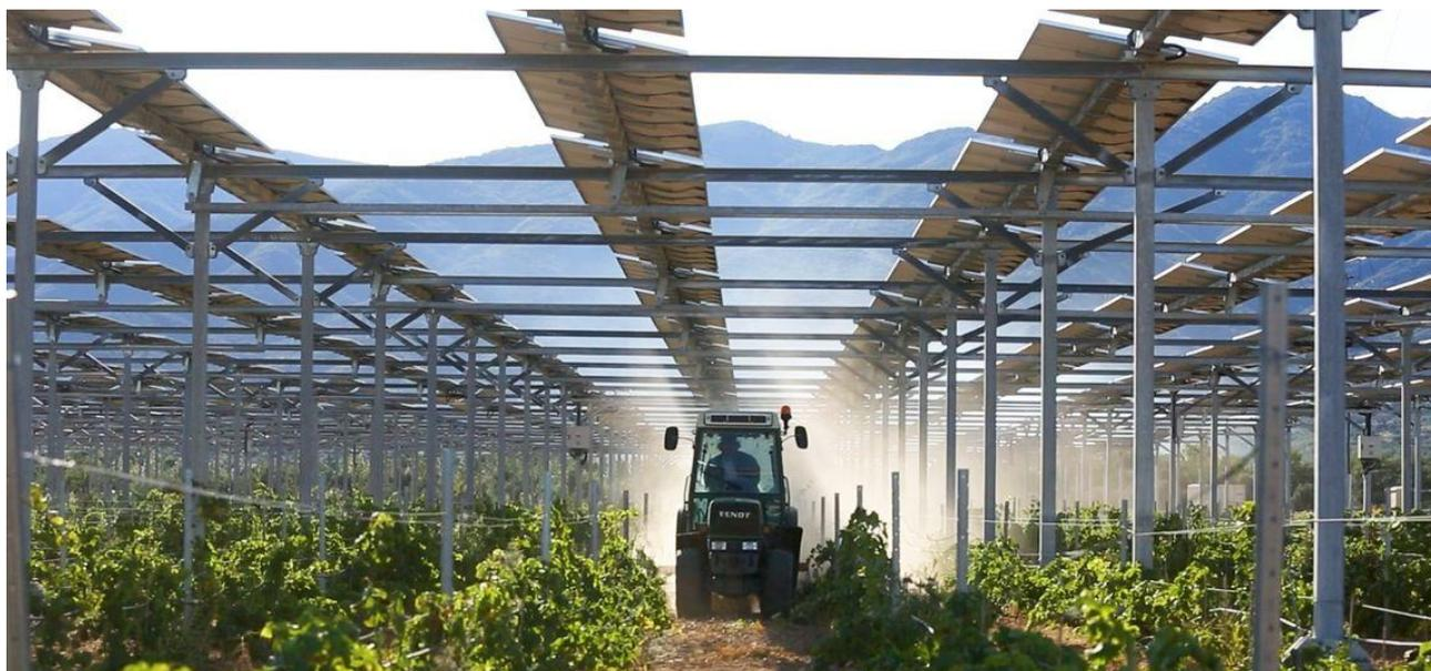
**Exemple d'agrivoltaïsme, avec modules à inclinaison contrôlable**
